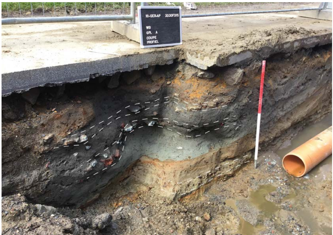
Afb. 32. Zicht op het oostelijk deel van de werken in de Maagdenstraat met aanduiding van verschillende wegniveaus.
