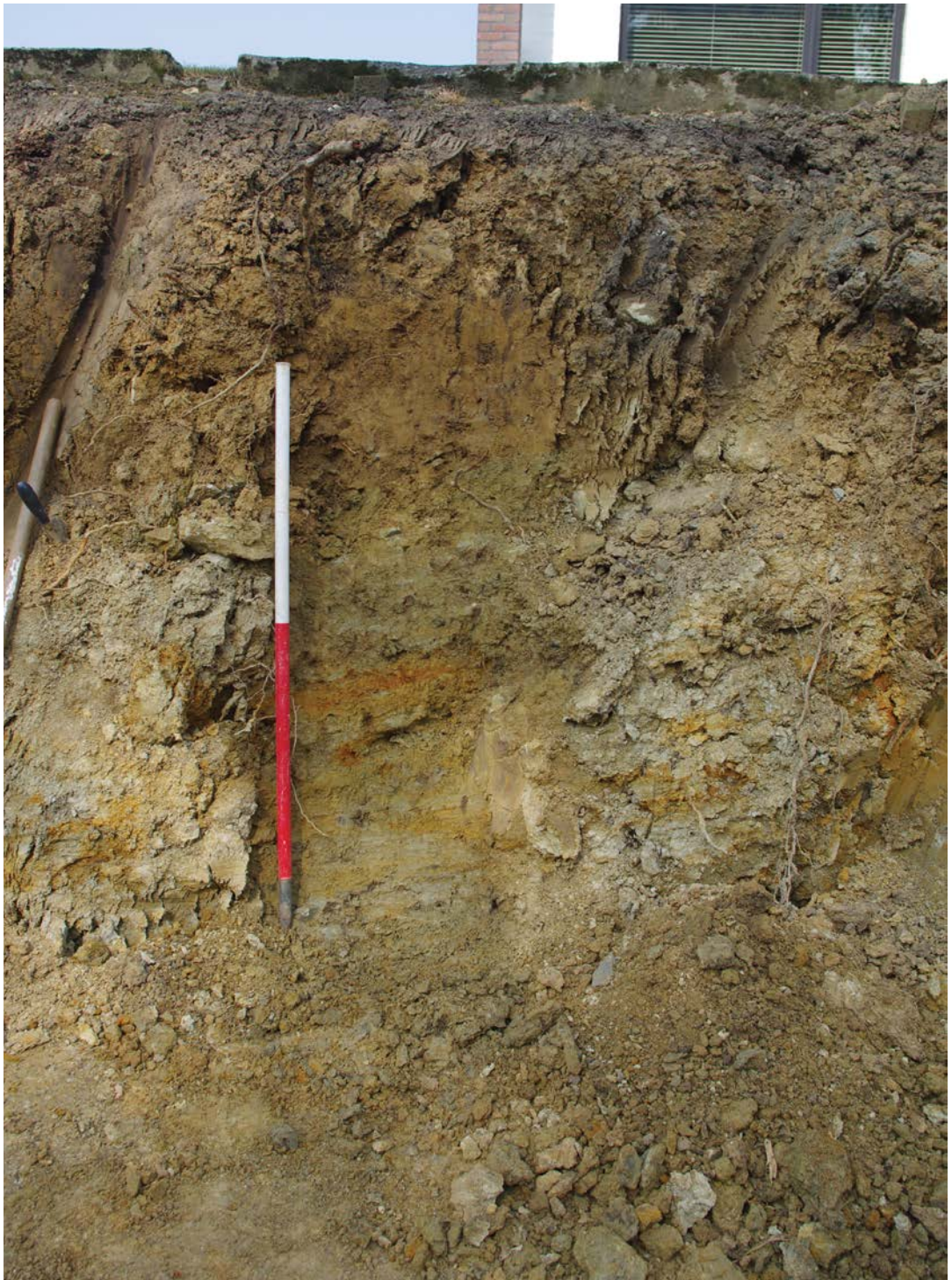
Afb. 28. Detail van de tertiaire pakketten ter hoogte van de zijberm van Schoonboeke 25.
