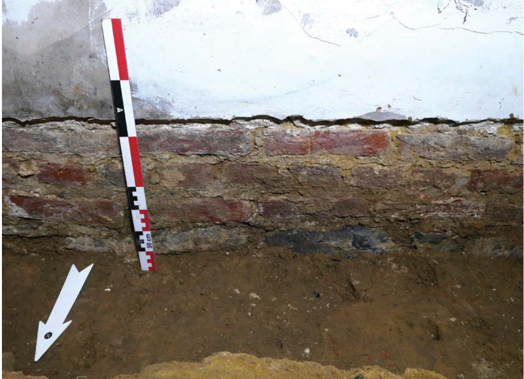
Afb. 30. Fundering III-5 van de kerkmuur uit 1901-1902.
