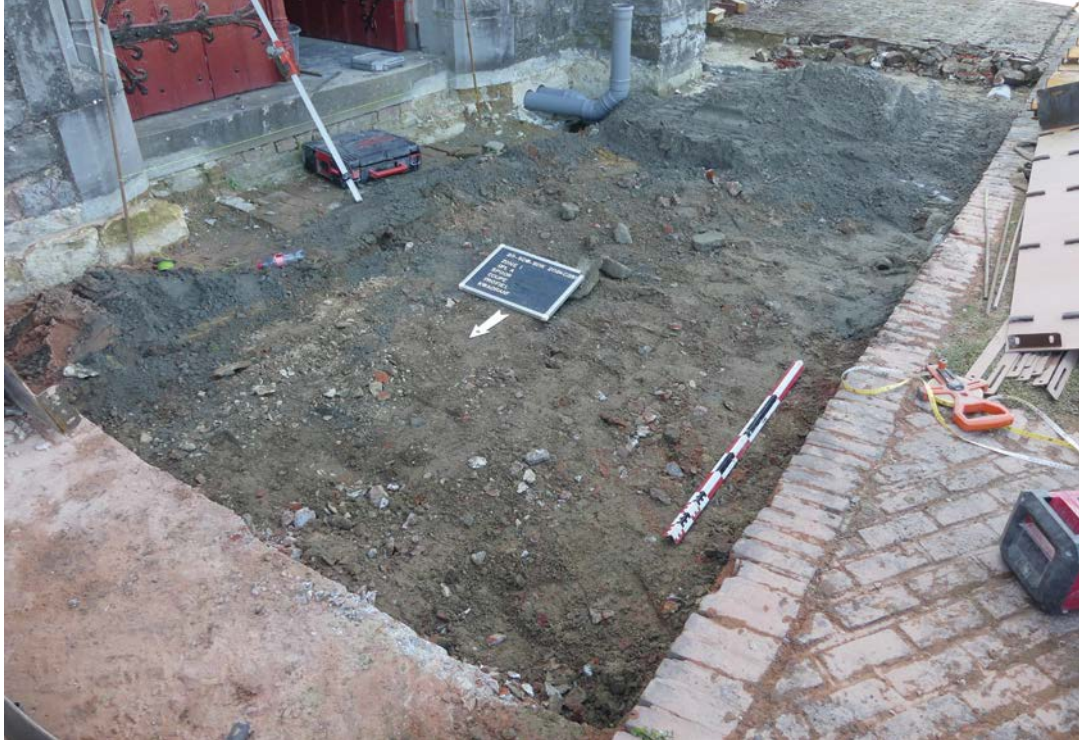
Afb. 8. Een gedeelte van de betonplaat werd later nog verwijderd voor de funderingszool van de nieuwe helling voor rolstoelgebruikers.
