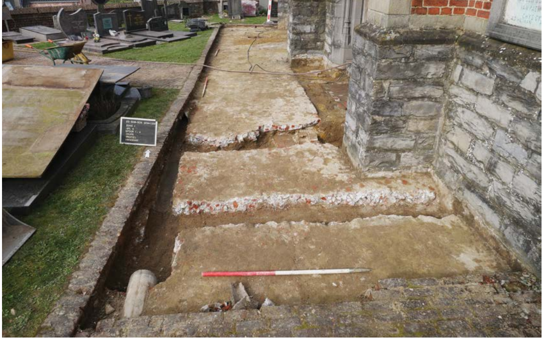
Afb. 14. Zone I na het machinaal verwijderen van het kerkhofpad en de manuele uitgraving van twee sleuven. In een latere fase werd de betonplaat voor de ingang van het westportaal uitgebroken (zie afb. 8).
