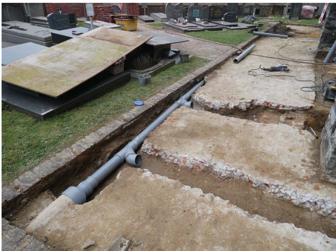
Afb. 2. De nieuwe afvoer voor het regenwater volgt het traject van een reeds aanwezige regenwaterafvoer. Hierop komen de twee aansluitingen met de nieuwe sanitaire ruimte vanuit de kerk.
