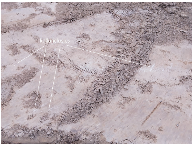
Figuur 5. Tijdens het afgraven werden regelmatig kalkbrokken waargenomen in de bovenste laag van de bodem.
