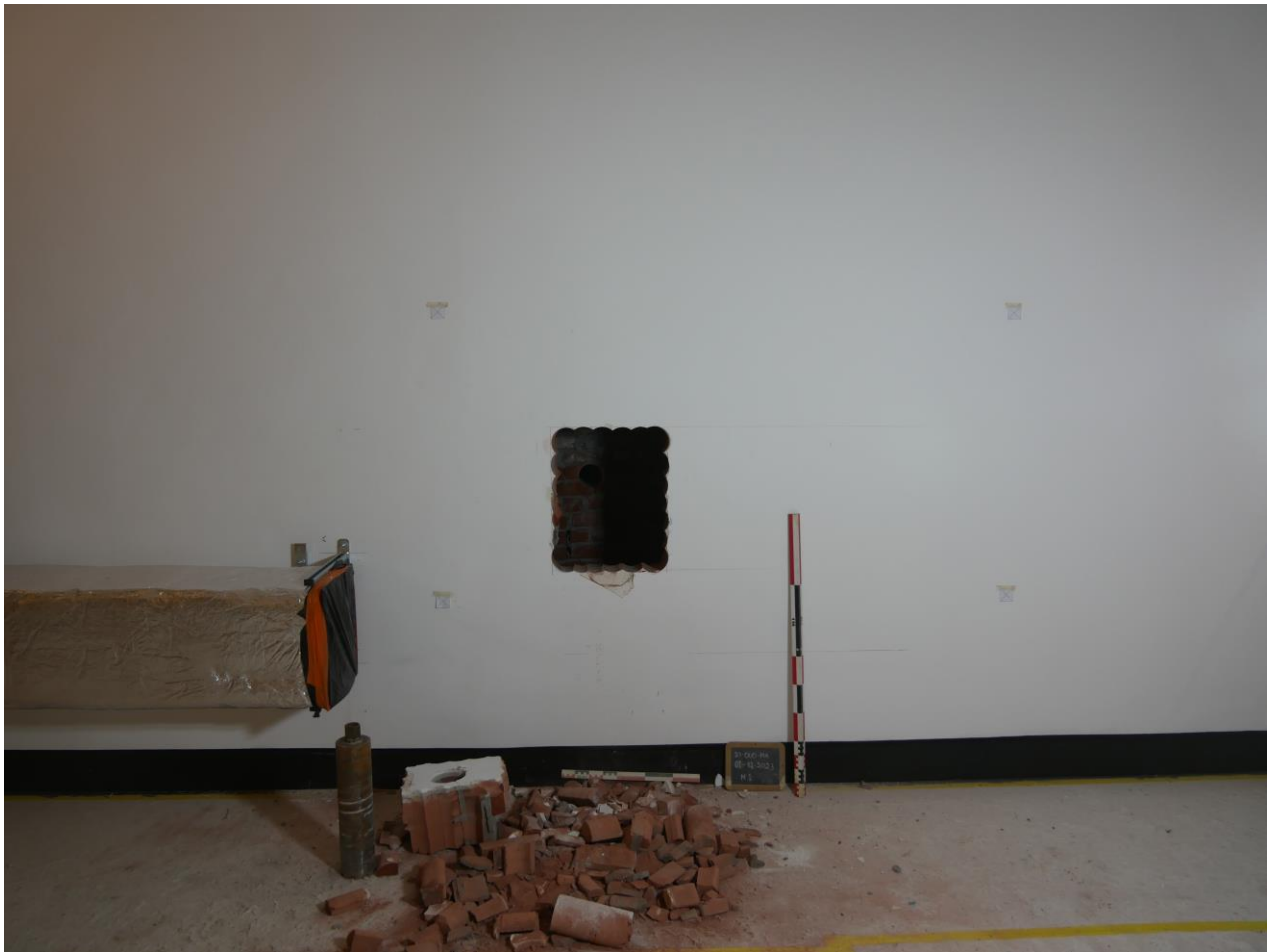
Figuur 5. Zicht op de uitbreiding van de eerste boring in de muur van de museale ruimte (muur 1), tot een opening van 51 x 41 cm.
