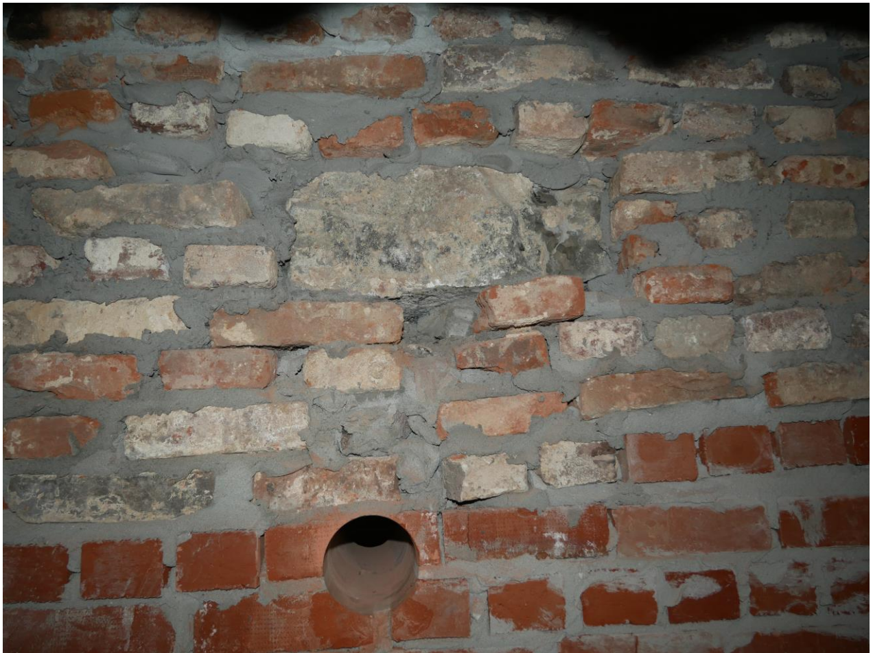
Figuur 4. Zicht op de boring in de bakstenen muur in de holte tussen de museale ruimte en de muur tegen de muur in Doornikse kalksteen of "buitenmuur" (muur 6).
