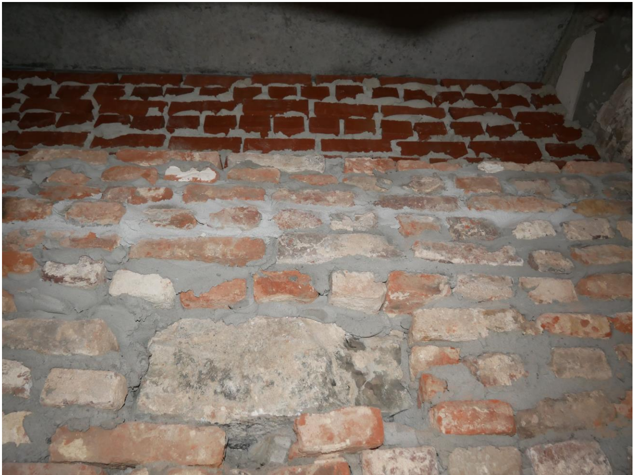
Figuur 6. Zicht op de bovenkant van de muur in de holte tussen de museale ruimte en de muur in Doornikse kalksteen, of "buitenmuur" (muur 6).
