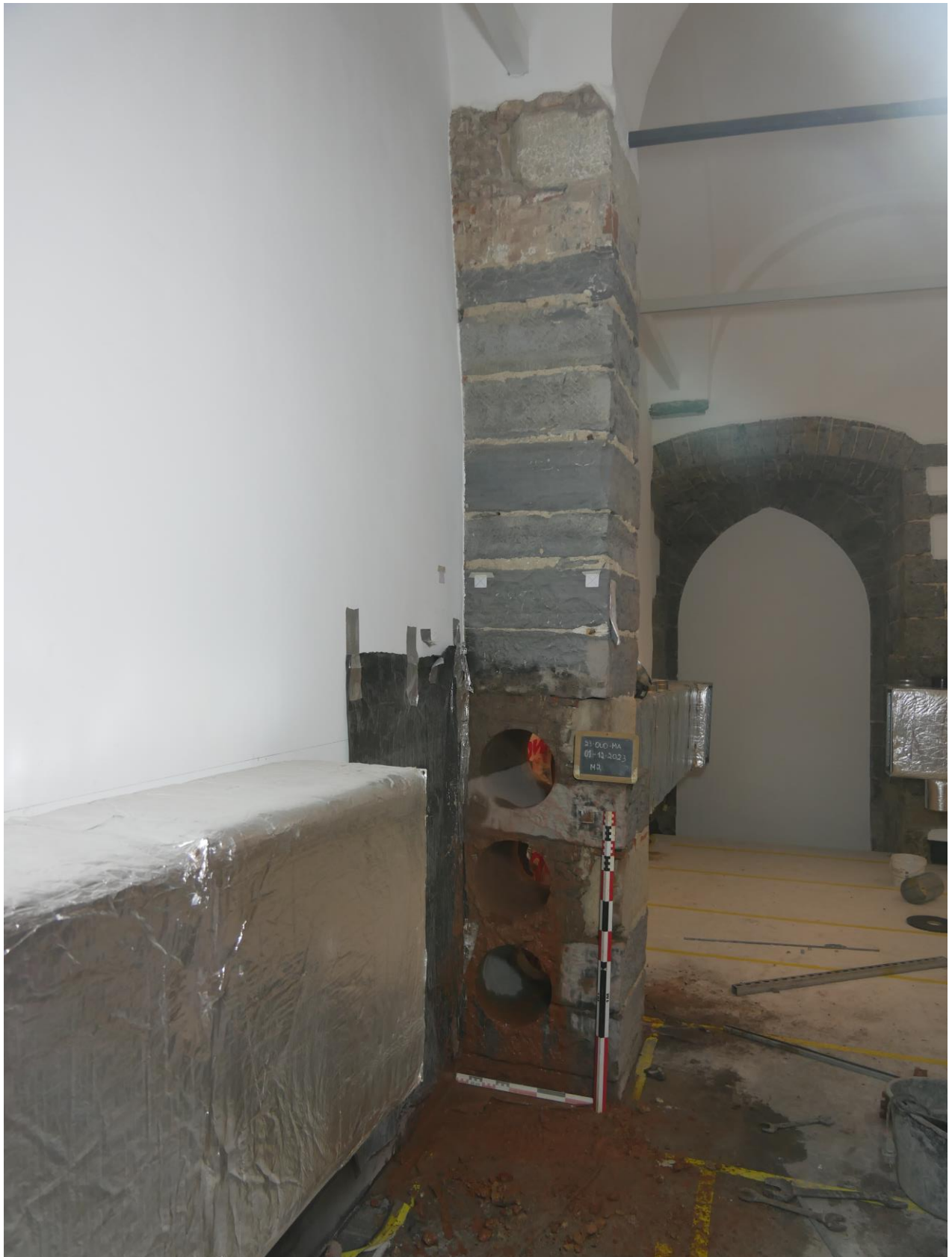
Figuur 12. Zicht op de drie boringen in de noordelijke pijler.
