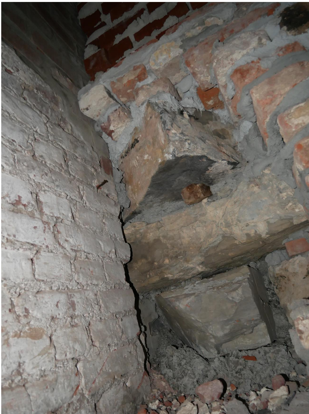
Figuur 8. Zicht op de opening in de bakstenen muur, dewelke toelaat de relatie tussen de dwarsmuur en de muur in Doornikse kalksteen te bepalen.
