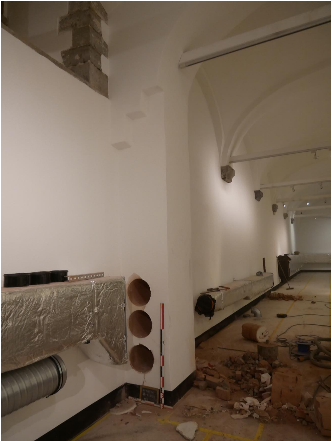
Figuur 16. Zicht op de drie boringen in de westelijke pijler.
