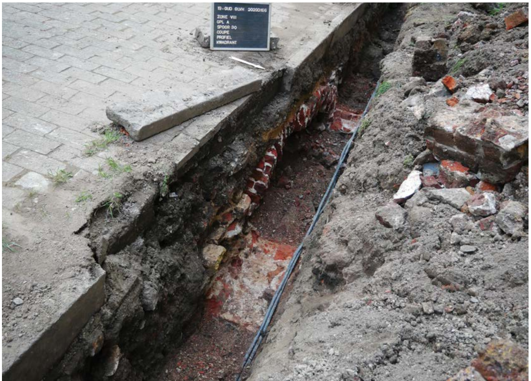
Afb. 40. Het bakstenen gewelf VIII-30 in de nutsleidingsleuf, buiten het projectgebied.
