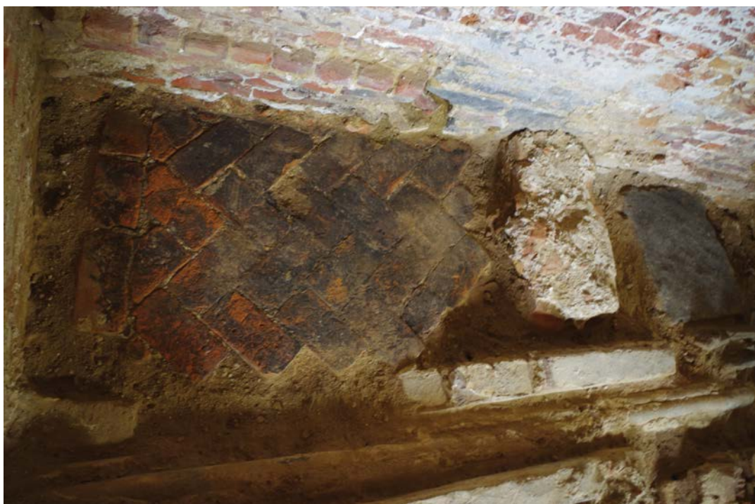
Afb. 8. Zuidoostelijke hoek van kamer 2. De kepvloer (C. VI-54) is afgewerkt, maar loopt niet tot tegen muur C. VI-60. De andere zijde van de vloer wordt duidelijk doorbroken door een recentere muur.
