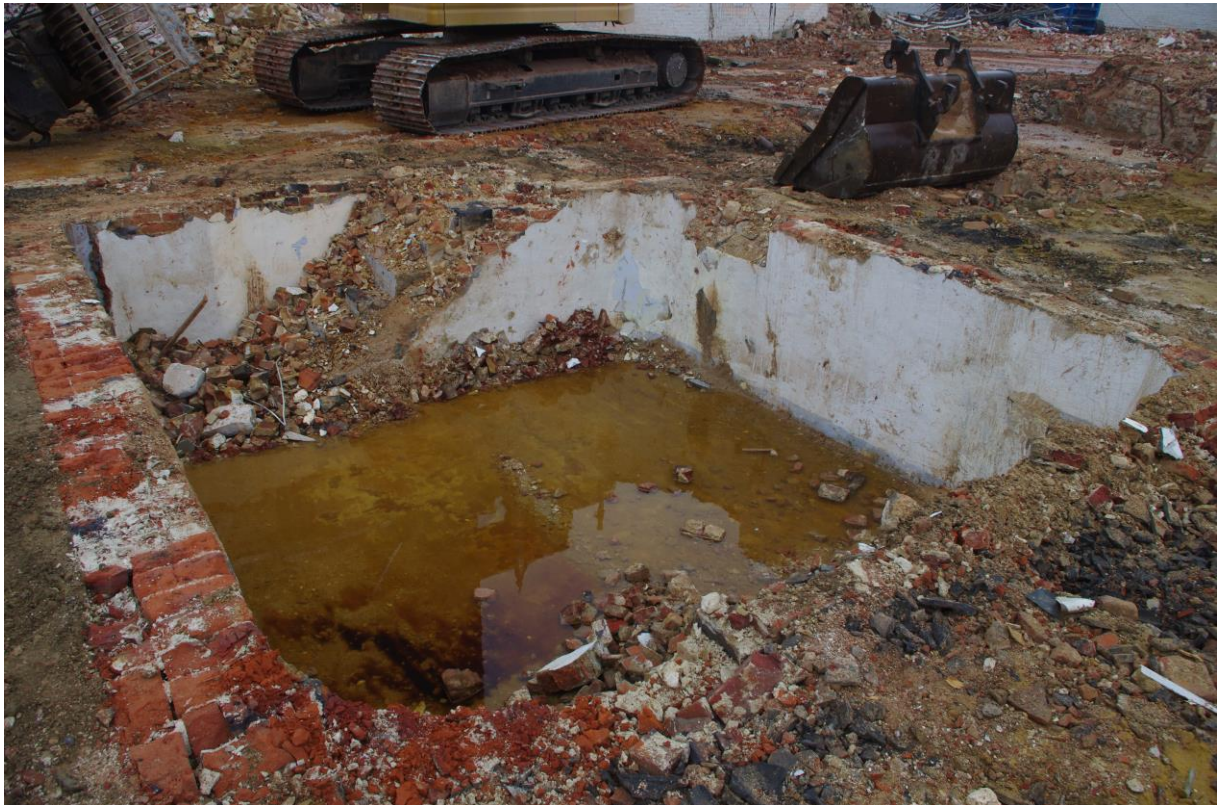
Figuur 22: Zuidelijke kelder (kelder 2).
