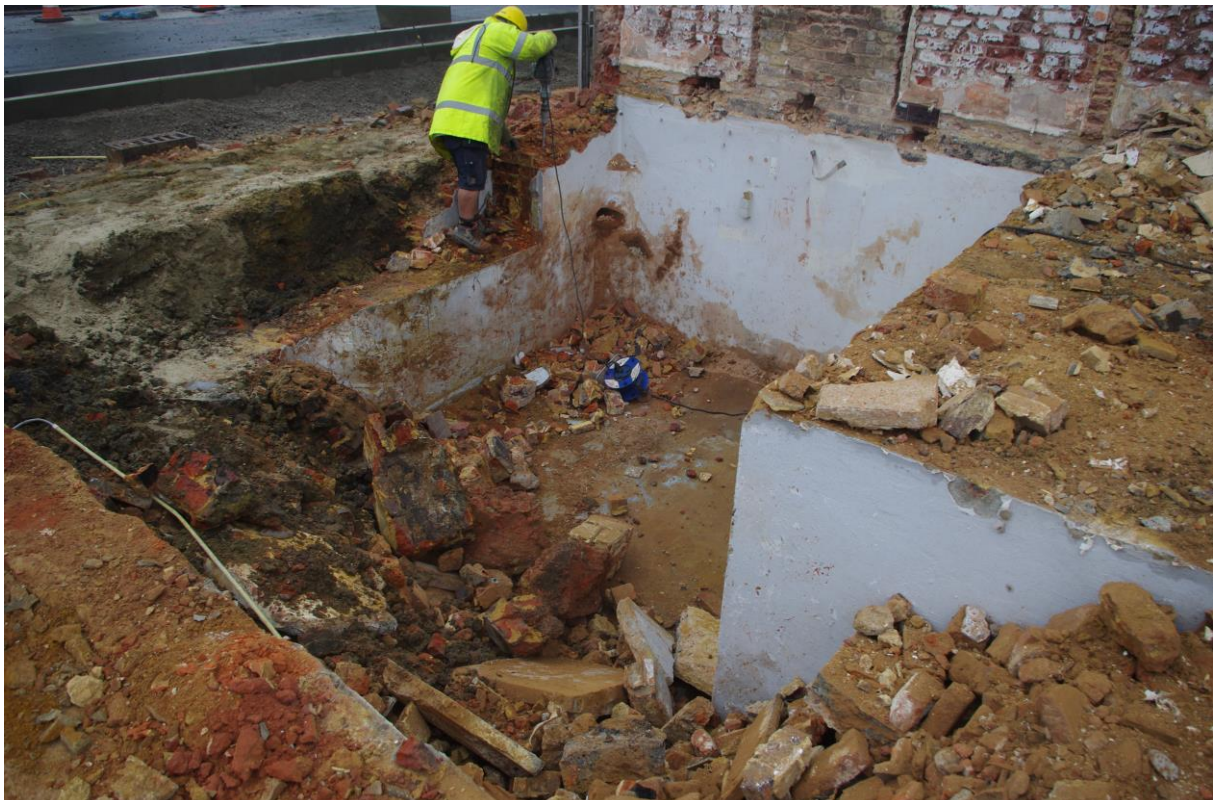
Figuur 21: Noordelijke kelder (kelder 1), grenzend aan het huis gelegen aan Bruul 6.
