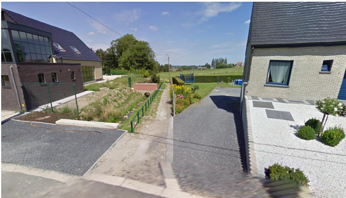
Foto 3: Zicht op zone 1 (aansluiting met de Driesleutelstraat) richting noorden (bron: Google Streetview, 2009)
