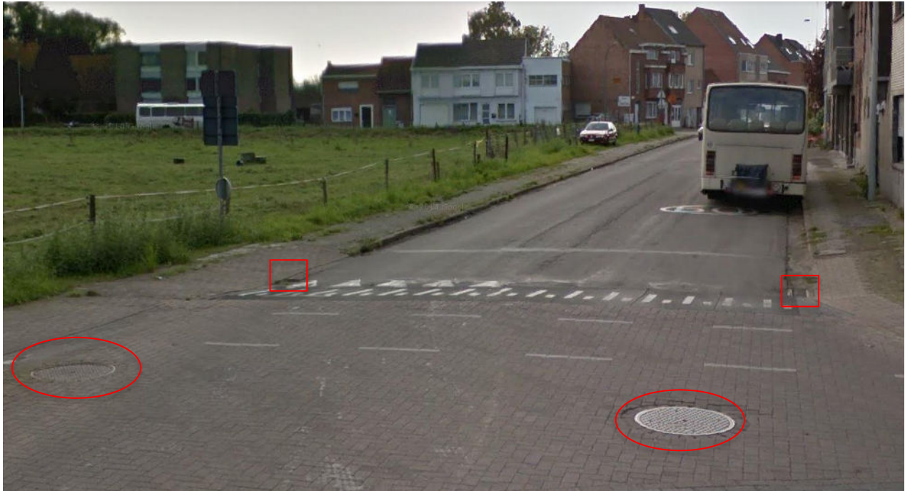
Foto 2: Zicht (richting zuidwesten) op de voormalige verkeersdrempel ter hoogte van de kruising van de Oude Dendermondse Steenweg en het Wijngaardveld, met aanduiding van de bestaande riolering naast en onder het wegdek (bron: Google Streetview 2013)
