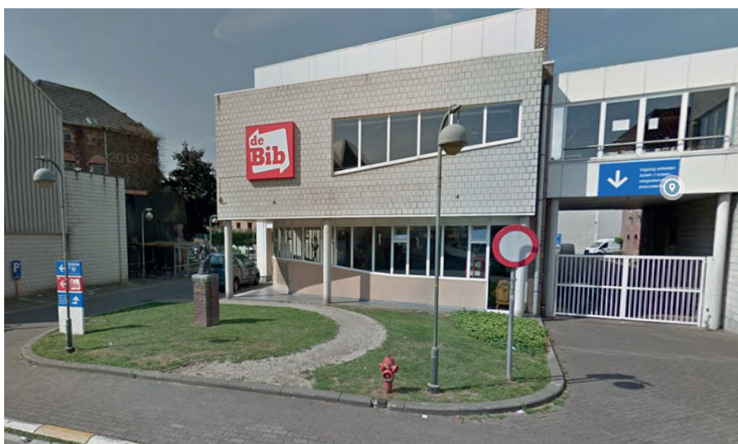
Afb. 1. Zicht op de bestaande toestand van het onderzoeksterrein vanuit het zuiden, vanop de Despauterstraat ©Google Maps. Beeld genomen op 24/03/2025).
